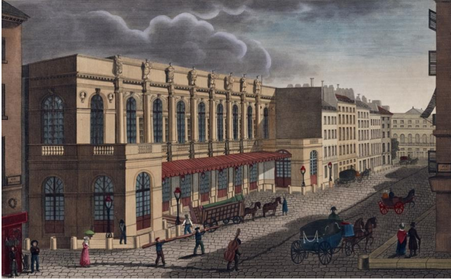
3. Vue de la nouvelle salle de l'Opéra prise de la rue de Provence, 1821.
