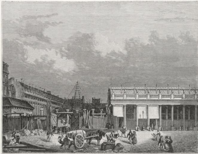
Fig. 38. — Construction de la galerie d'Orléans (1829).
