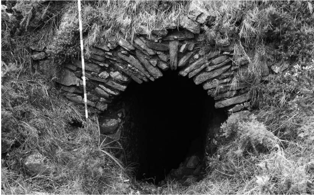
Abb. 10 San Pedro (Genalguacil, Málaga). Gemauerter Eingang zur Mine.
