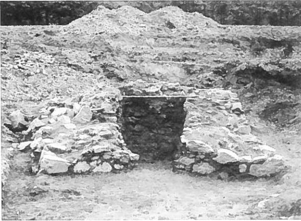
Abb. 1: Mauerreste des Floßofens in der Jubach-Talsperre bei Kierspe. Hinter dem Ofen ( im Bild rechts) befand sich unter einer Holzkohlenlage eine Schüttung aus glasigen Schlacken, die auf Walnußgröße gepocht waren und bei der Verhüttung zugeschlagen wurden.
