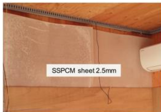
Fig.5 SSSPCM sheet installation [97, 98].
