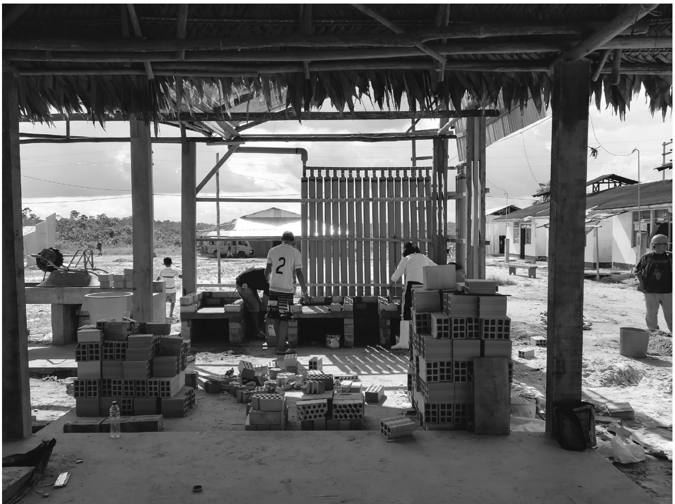
Figura 4. Proceso de construcción de la cocina ecológica en la maloca de la Nueva Ciudad de Belén. Fotografía del equipo CASA
